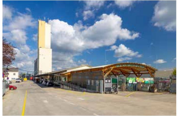
Standort Betrieb Mannersdorf
